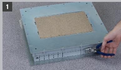
Прорезать входы для кабель-канала
