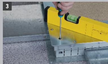
Отрегулировать с помощью винтов
